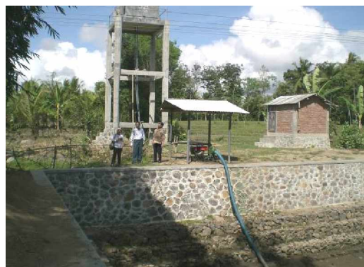
Bangunan Irigasi Pompa
